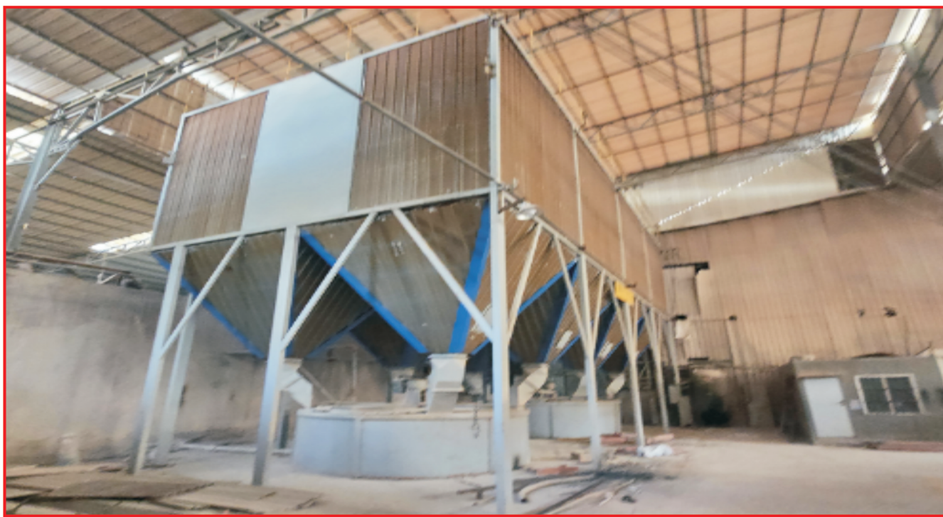
陶瓷行业废气处理设备现场
